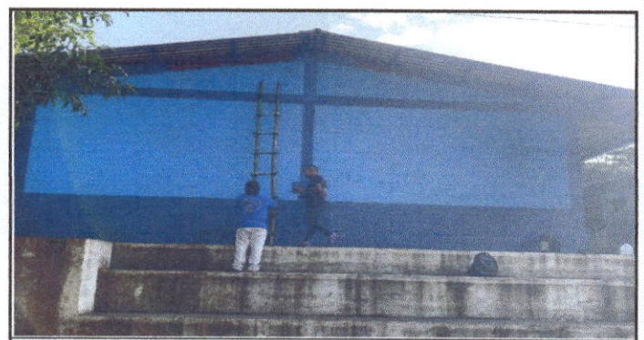
Foto 6 Avance de pintura de exteriores e interiores
