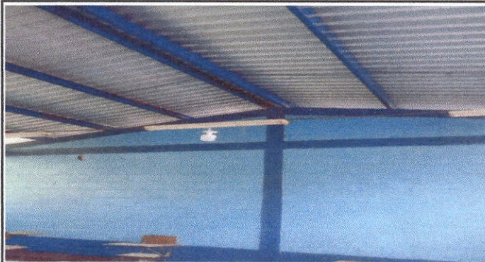
Foto 3 Reparación de sistema electrico
